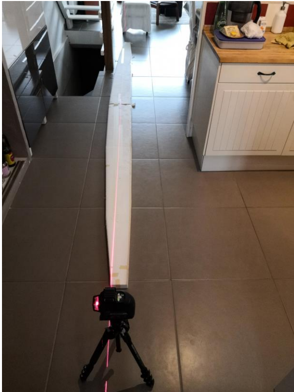
Alignement des noyaux pour repère au laser
